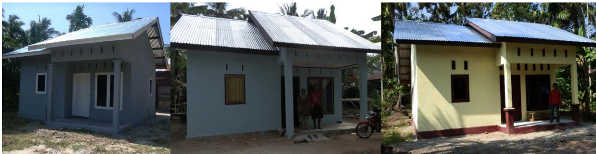
Gambar 3.1 Prasarana, Sarana Utilitas Umum (PSU) Rumah Layak Huni Kabupaten Bengkalis
