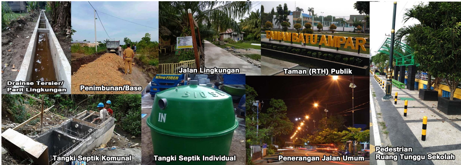
Gambar 3.1 Prasarana, Sarana Utilitas Umum (PSU) Kabupaten Bengkalis
